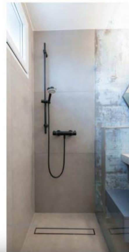
Badzimmer nach dem Umbau (Fallbeispiel 01)
